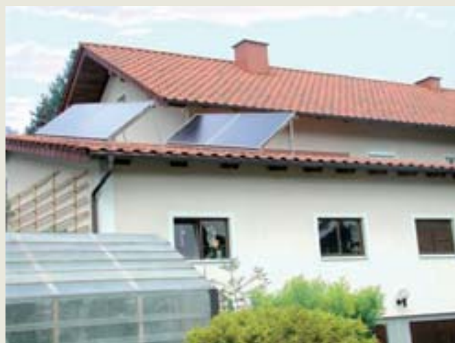
Obr. Sériově může být zapojeno až 6 ks kolektorů BSK nadstřešních.
