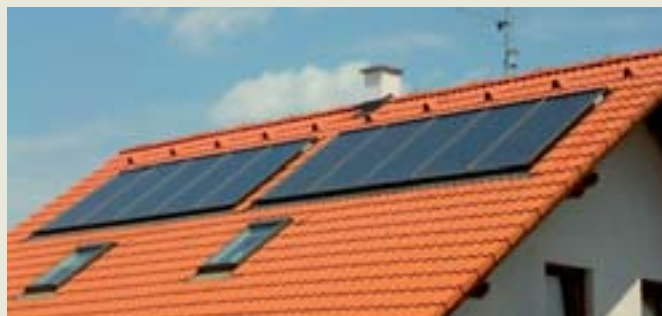
Obr. Pro solární systémy využívané i k pítápění se u rodinných domků používá kolektorová plocha 12 až 20 m 2 .
