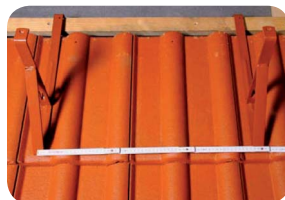
Obr. 2 - Max. rozteč držáků
