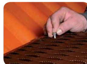
Obr. 5 - Připevnění stoupací plošiny u ŘT
