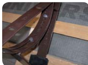
Obr. 3 - Připevnění držáku k závěsnému háku
