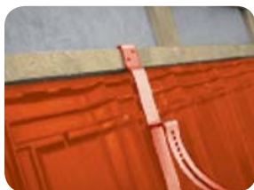
Obr. 8 - Připevnění závěsného háku
