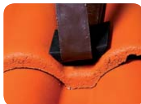
Obr. 2 - Nasazení pryžové podložky u ŘT
