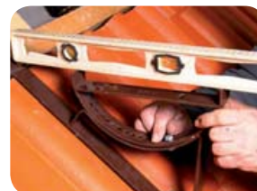
Obr. 4 - Kontrola horizontální polohy držáku
