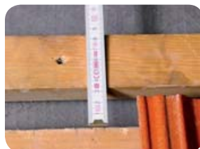
Obr. 1 - Poloha mezilatě pro zavěšení háku
