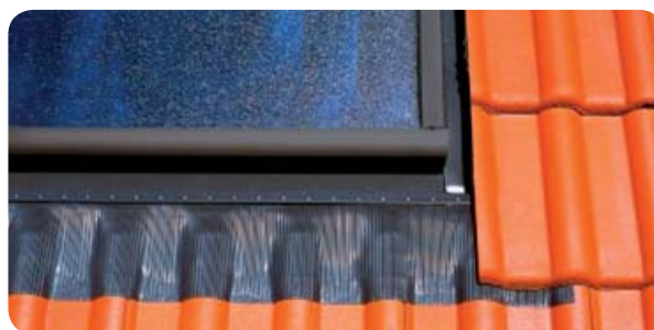
Obr. Detail napojení na krytinu. Pro zvýšení estetické hodnoty detailu je vhodné použít zakončovací tašky (tašky bez vodního zámku) při pravém okraji kolektoru.
