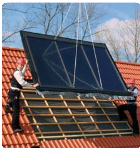
Obr. Solární kolektory pro integraci do krytiny se montují pomocí jeřábu. Montáž je tak velmi rychlá. Nainstalování kolektoru trvá cca 1 hodinu.
