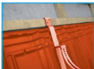
Obr. 8 - Připevnění závěsného háku
