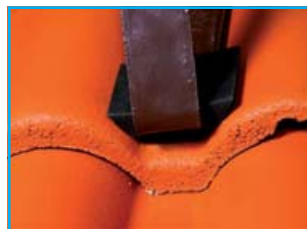
Obr. 2 - Nasazení pryžové podložky u ŘT
