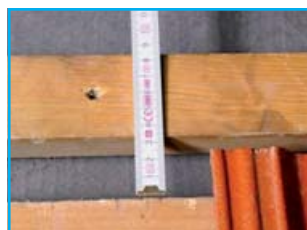
Obr. 1 - Poloha mezilatě pro zavěšení háku
