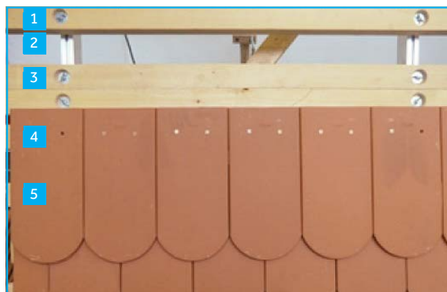
Obr. 9 - Popis k obrázku (vzdálenost latí je 145 mm) 1 - střešní lať, 2 - mezilať, 3 - střešní lať, 4 - střešní lať, 5 - střešní lať
