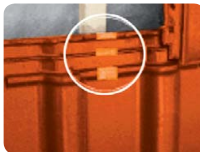
Obr. 8 Úprava drážky
