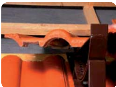
Obr. 7 Drážka v tašce pro překrytí háku
