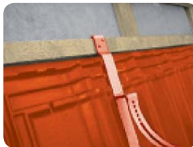
Obr. 9 Připevnění závěsného háku
