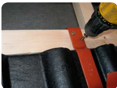
Obr. 3 Upevnění háku k mezilati
