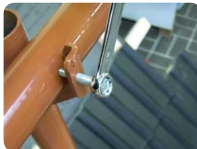
Obr. 15 Upevnění vodorov- ných tyčí zábradlí
