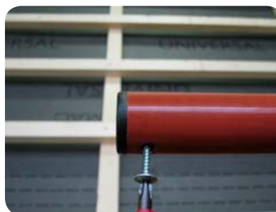
Obr. 16 Krytky a jejich zajištění
