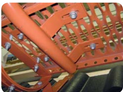
Obr. 13 Připevnění stojek zábradlí pomocí čtyř šroubů
