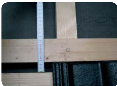
Obr. 1 Vzdálenost mezilatě 85 mm
