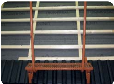
Obr. 12 Připevnění stojek zábradlí
