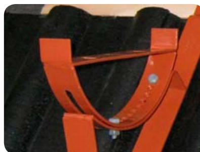
Obr. 5 Upevnění držáku do závěsného háku
