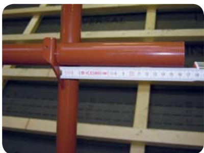
Obr. 14 Kontrola polohy vodorovných tyčí zábradlí
