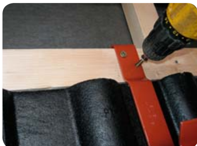
Obr. 3 Upevnění háku k mezilati
