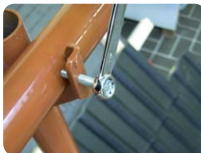
Obr. 15 Upevnění vodorovných tyčí zábradlí
