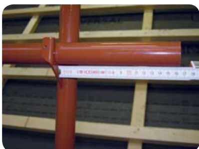
Obr. 14 Kontrola polohy vodo- rovných tyčí zábradlí
