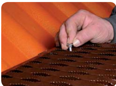
Obr. 6 Připevnění stoupací lávky
