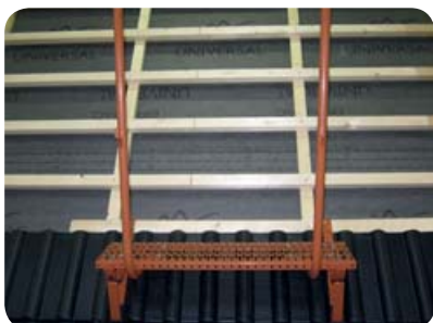
Obr. 12 Připevnění stojek zábradlí
