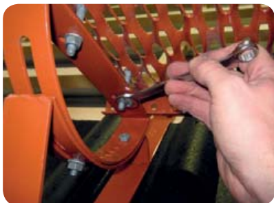
Obr. 6 Připevnění stoupací lávky
