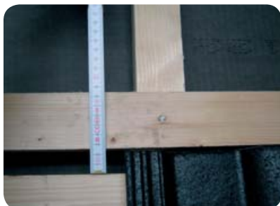
Obr. 1 Vzdálenost mezilatě 85 mm
