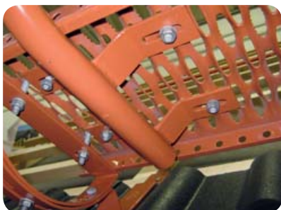
Obr. 13 Připevnění stojek zábradlí pomocí čtyř šroubů
