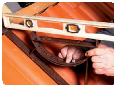
Obr. 4 Kontrola horizontální polohy držáku
