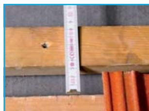
Obr. 1 - Poloha mezilatě pro zavěšení háku
