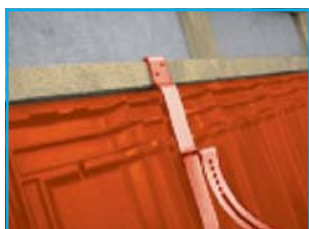
Obr. 8 - Připevnění závěsného háku
