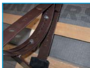
Obr. 3 - Připevnění držáku k závěsnému háku
