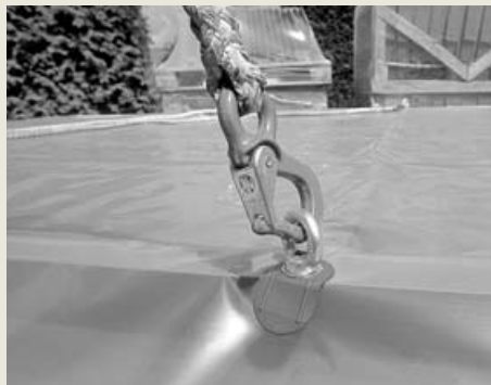
Zavěsit zvedací lano – hák na kolektor
