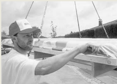
Rozříznout fólii a vybalit kolektor
