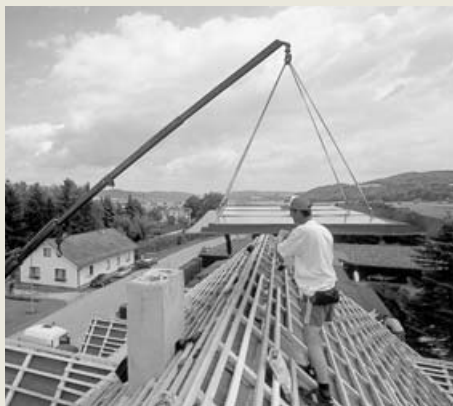
Vyzvednutí kolektoru na střechu ve vodorovné poloze
