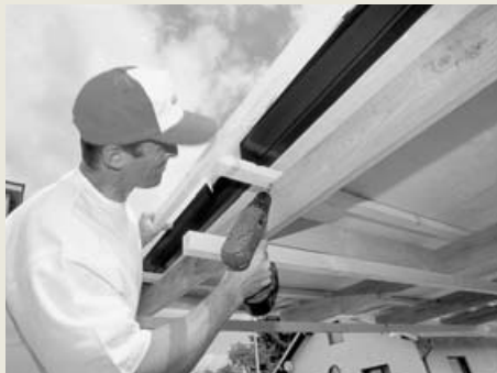
Odmontovat dřevěnou konstrukci z kolektoru (včetně latě při horní hraně kolektoru)
