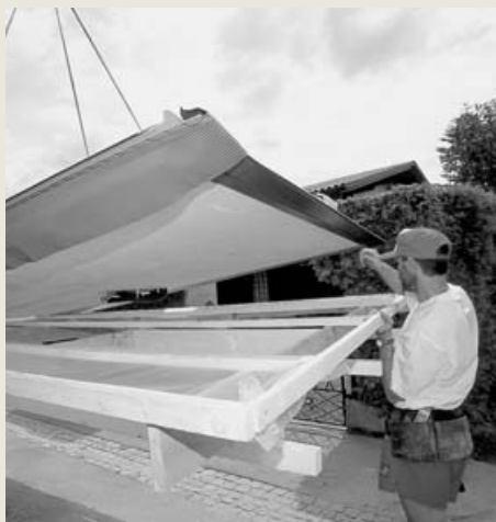
Sejmout dřevěnou konstrukci z kolektoru
